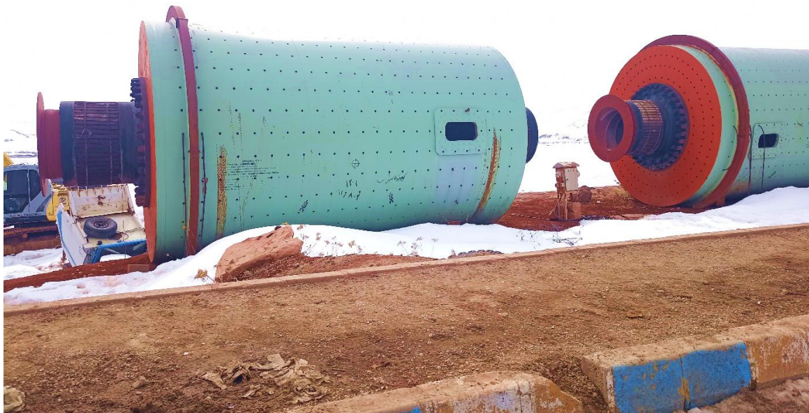
پروژه تعمیر تجهیزات صنعتی
