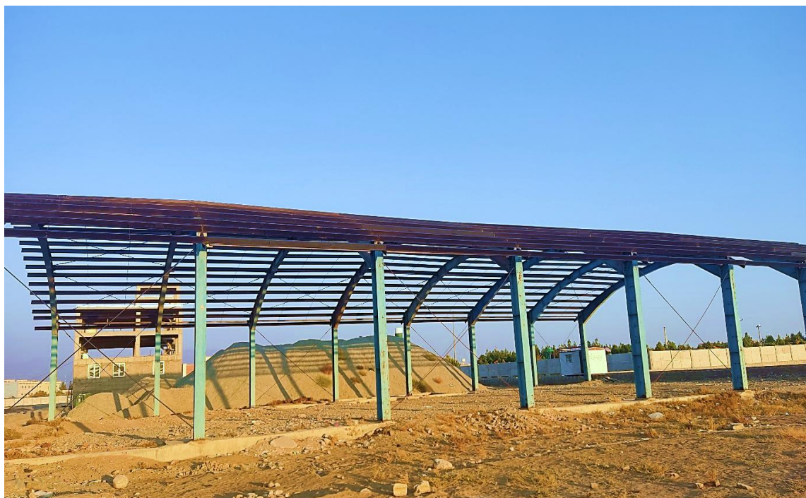
پروژه سوله کرج
