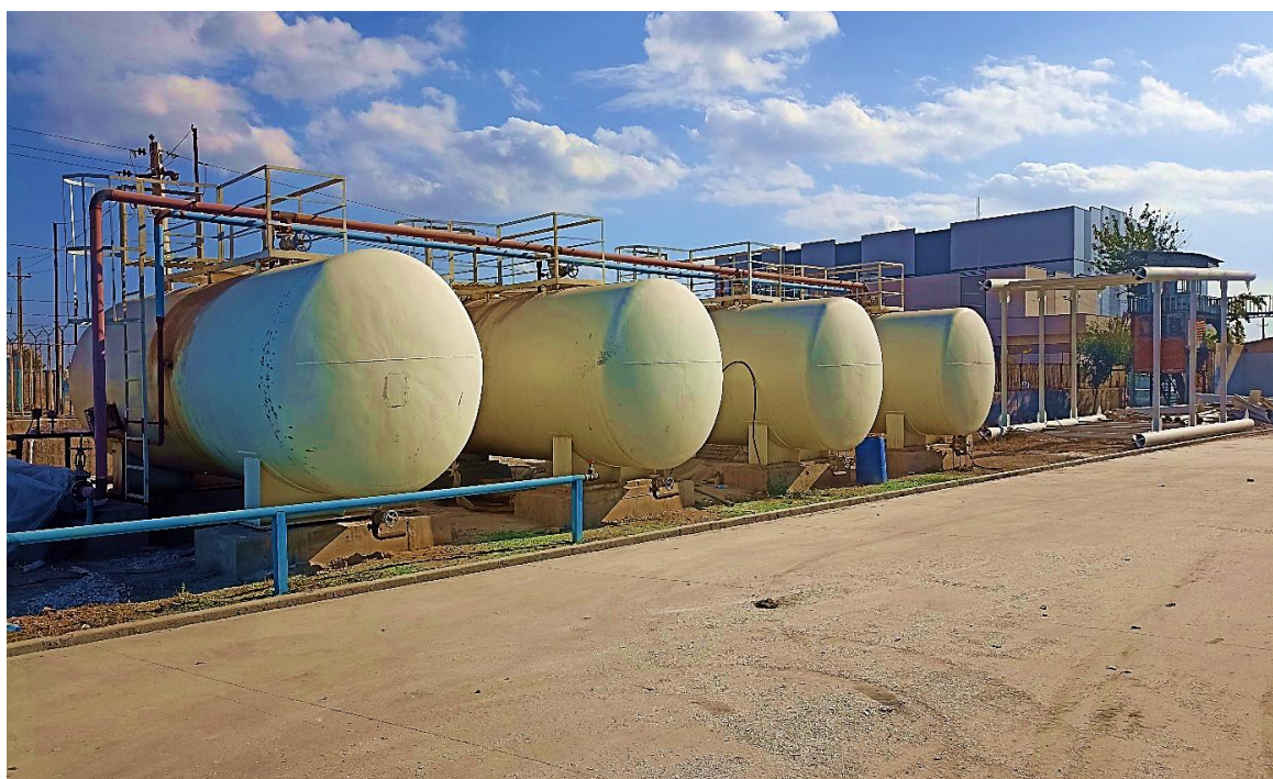
پروژه مخازن ذخیره گازوئیل شهرک صنعتی البرز
