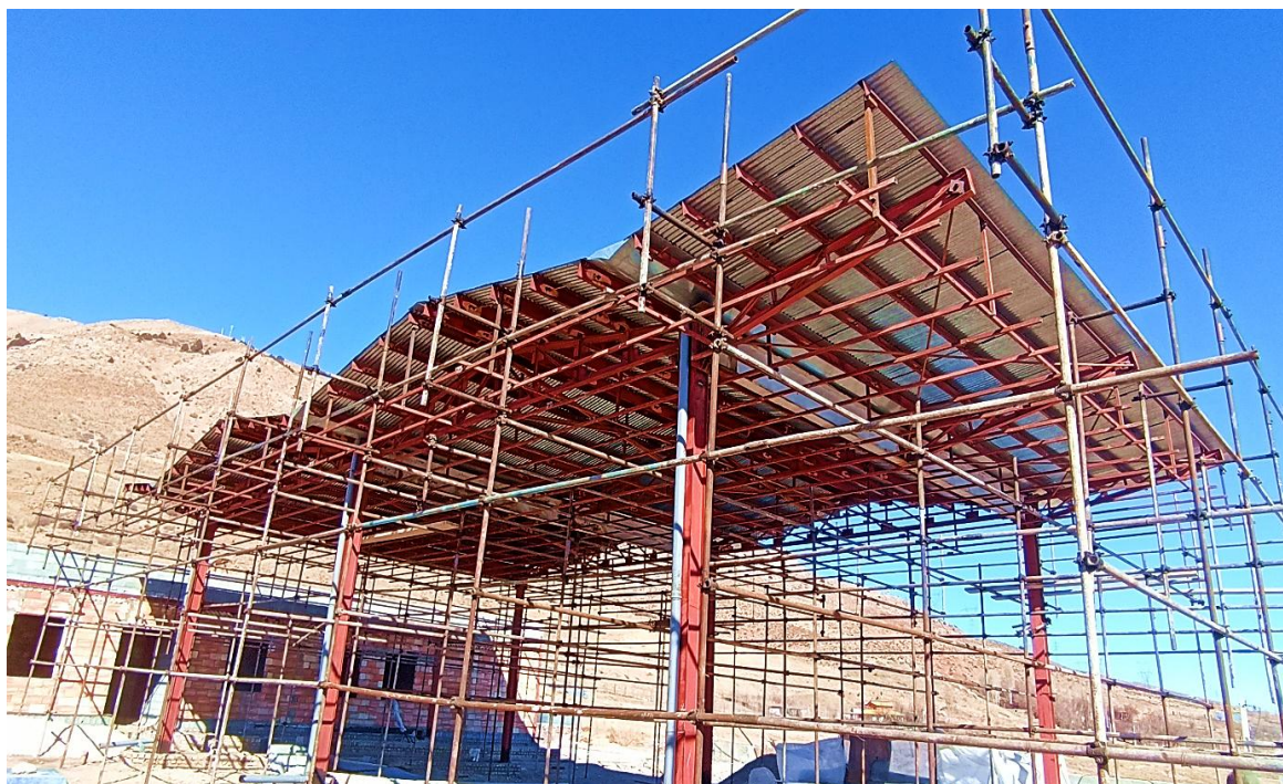
پروژه پمپ بنزین جاده فیروزکوه
