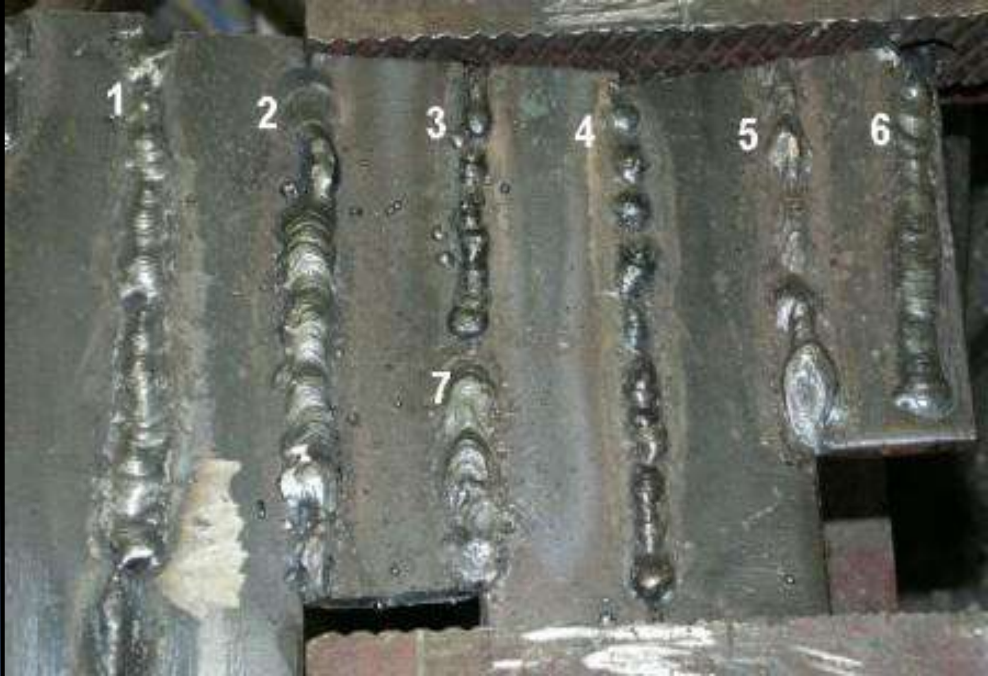
نمای چند خط جوش معیوب
