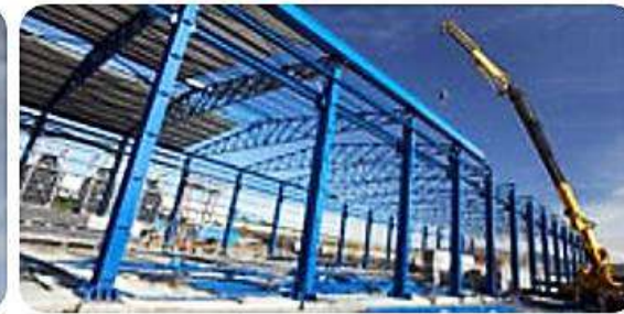
ساخت و نصب انواع سازه فلزی
