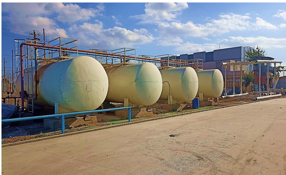
پروژه مخازن ذخیره گازوئیل شهرک صنعتی البرز
