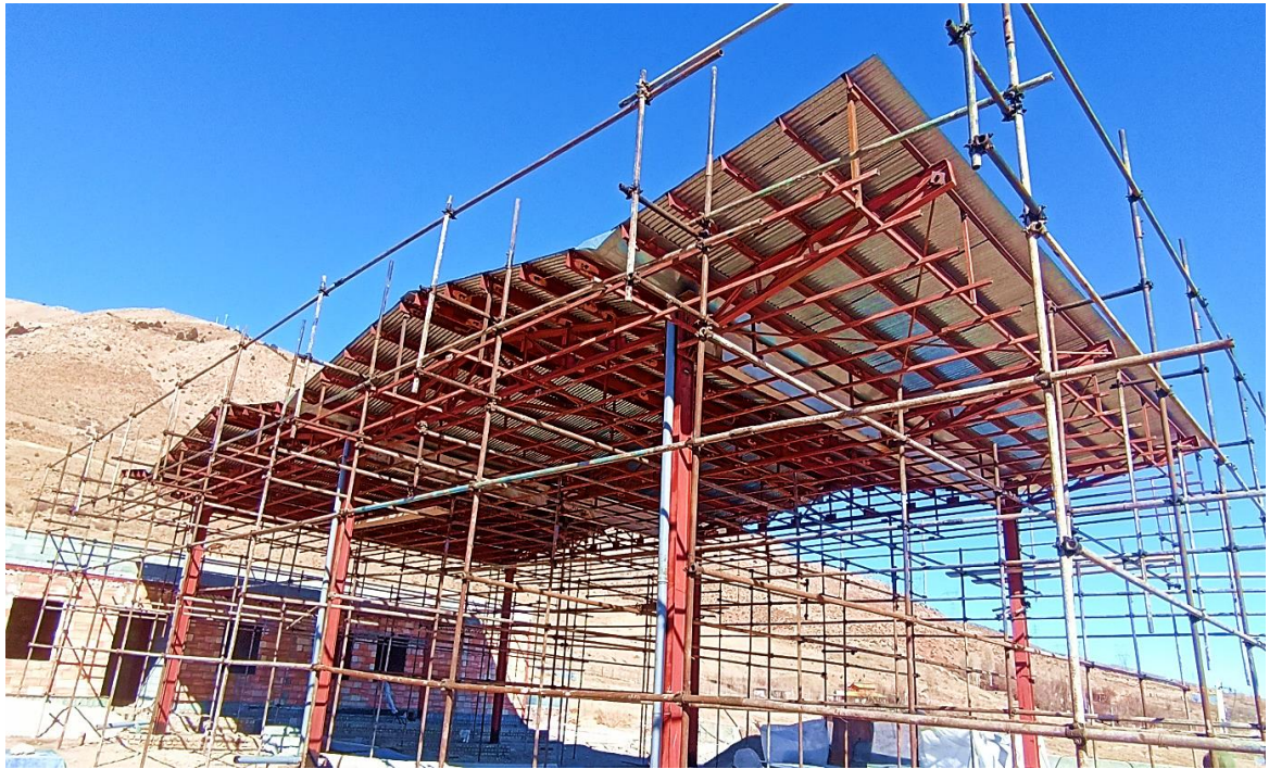
پروژه پمپ بنزین جاده فیروزکوه
