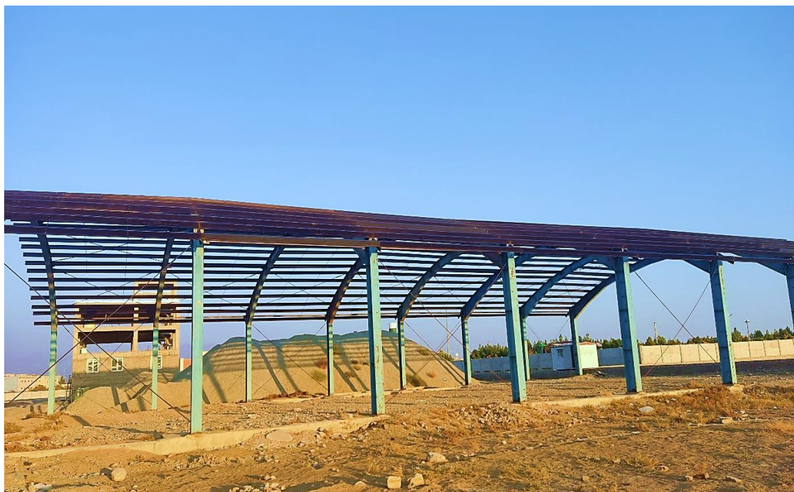
پروژه سوله کرج
