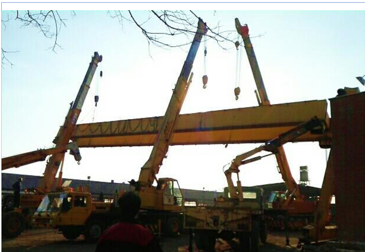
پروژه جرثقیل سقفی
